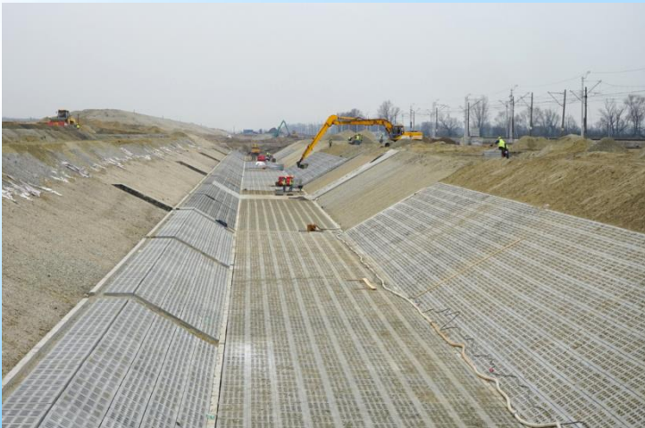
Przełożone koryto rzeki Psiny
