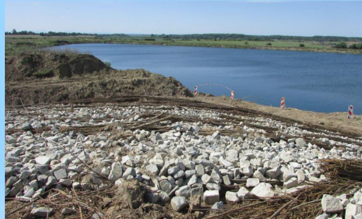
Umocnienie korony wyspy hydrotechnicznej
