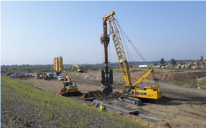
Wykonywanie przestony przeciwfiltracyjnej
