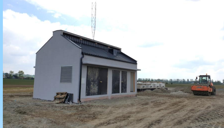
Rozdzielnia i pompownia Lubomia
