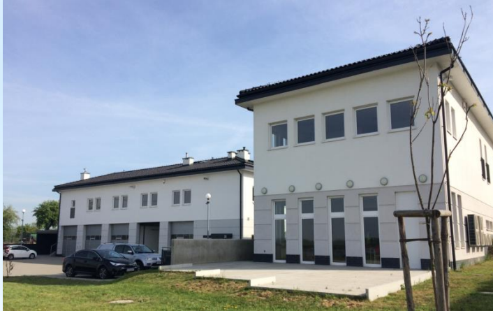
Budynek centralnej dyspozytorni zbiornika
