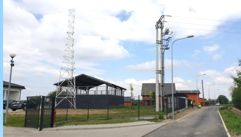
Droga dojazdowa D1
