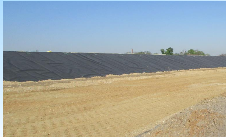
Doszczelnienie korpusu zapory
