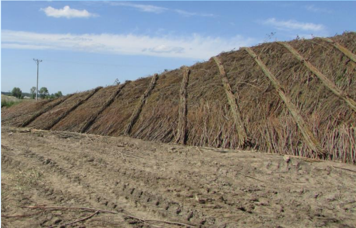
Umocnienie skarp wyspy hydrotechnicznej
